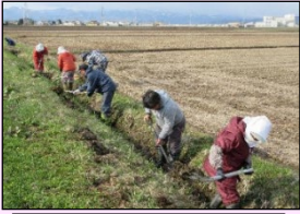
水路の泥上げ
