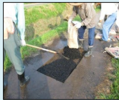
農道の部分補修
