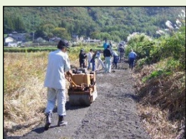
未舗装農道の舗装
