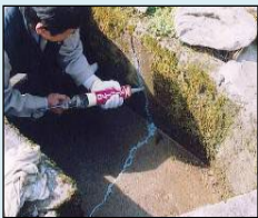
ひび割れの補修
