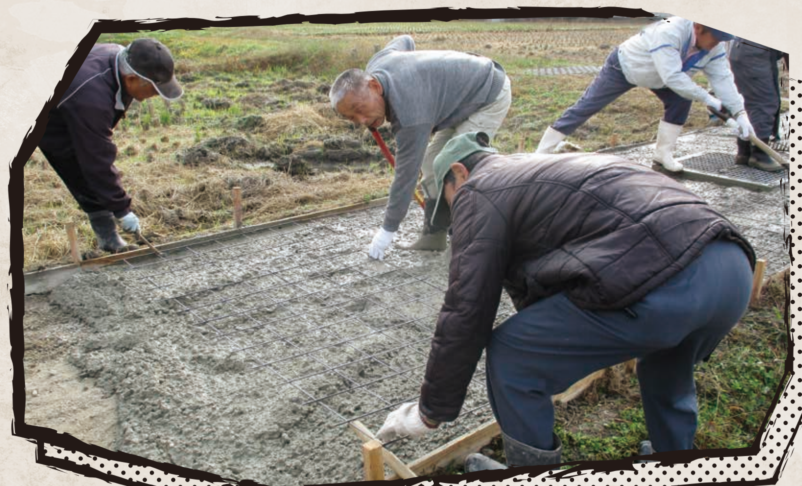
農道の舗装作業
