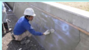
老朽化した水路壁のコーティング
