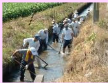
水路の泥上げ
