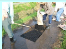
農道の部分補修
