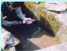
水路のひび割れ補修
