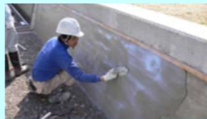
老朽化した水路壁のコーティング
