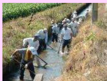
水路の泥上げ
