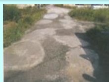
農道の窪みの補修
