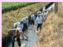
水路の泥上げ
