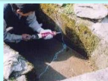
水路のひび割れ補修
