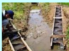
水田魚道の設置
