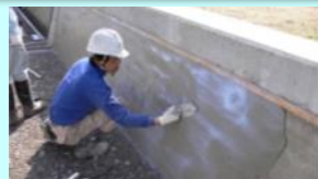
老朽化した水路壁のコーティング
