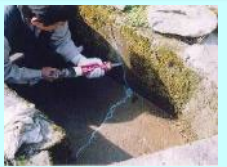
水路のひび割れ補修
