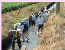
水路の泥上げ
