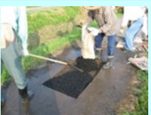
農道の部分補修
