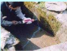
水路のひび割れ補修
