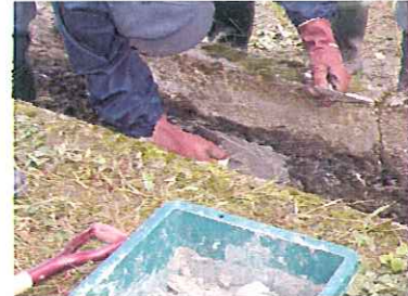
モルタルによる補修体験
