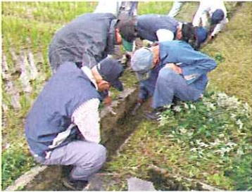
補修面の清掃作業
