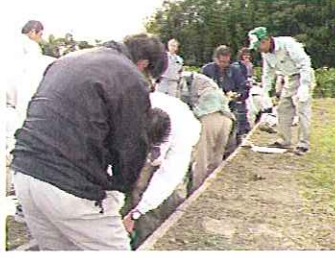
補修面の清掃作業
