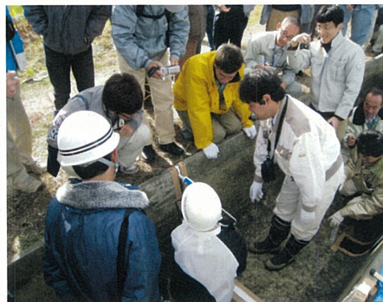
水路の目地詰め研修（南丹市園部町船岡） ＜船岡農地・水・環境保全向上対策委員会＞
